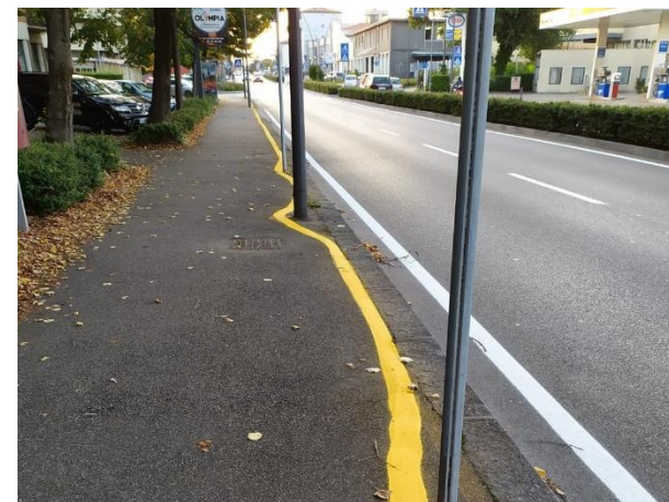
Percorso ciclo-pedonale con sezione inadeguata.
