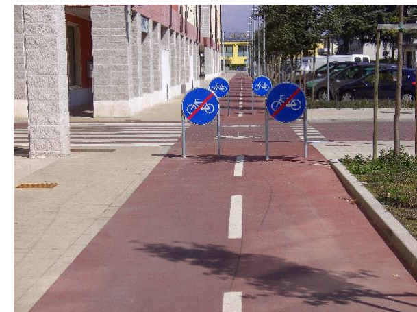
Segnale fine pista ciclabile su percorso ciclo-pedonale in prossimità di un attraversamento pedonale.
