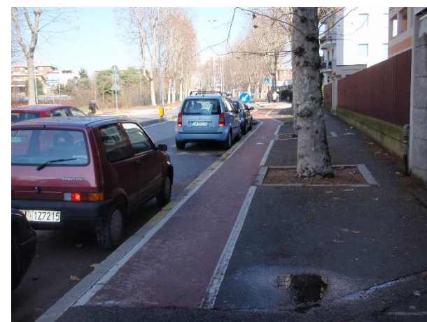
Percorso ciclo-pedonale con sezione inadeguata.
