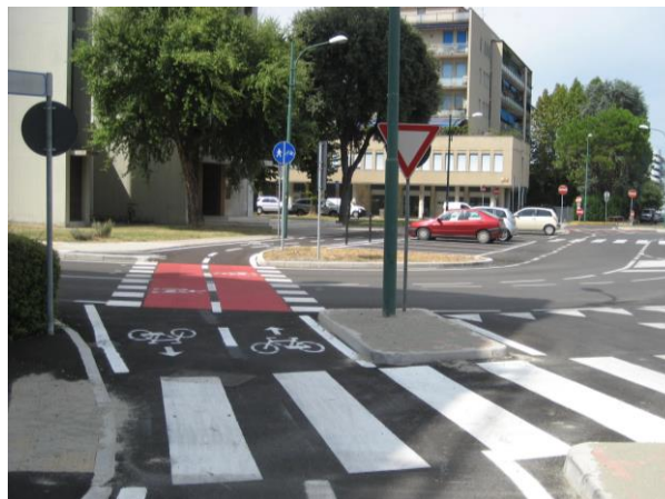
Attraversamento ciclabile ben segnalato
