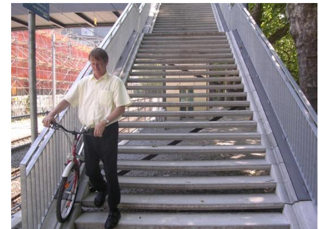
Canalina per il trasporto a mano delle biciclette su sovrappasso pedonale
