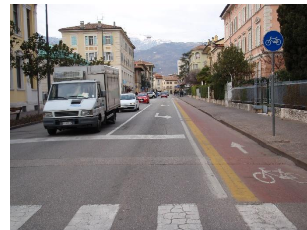
Pista ciclabile contromano non adeguatamente separata dalla carreggiata
