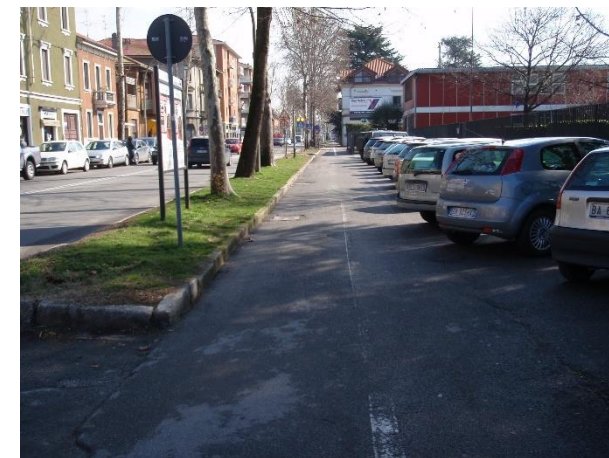
Punto di interferenza pericolosa con sosta a spina
