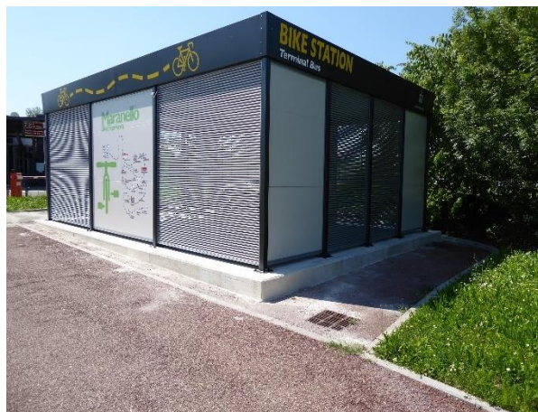
Ciclostazione in prossimità del Terminal Bus di Maranello.
